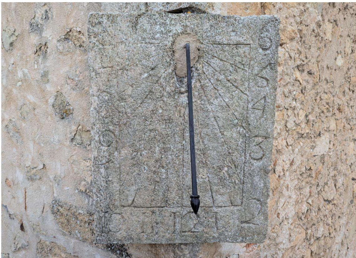
Figura 13. En la imagen se observa el reloj tras la limpieza de las zonas de concentración de líquenes y el aplique del mortero de cal a la oquedad del gnomon.
