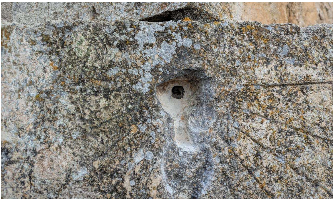
Figura 8. En la imagen se aprecia el taco químico introducido dentro del agujero del gnomon para su fijación.
