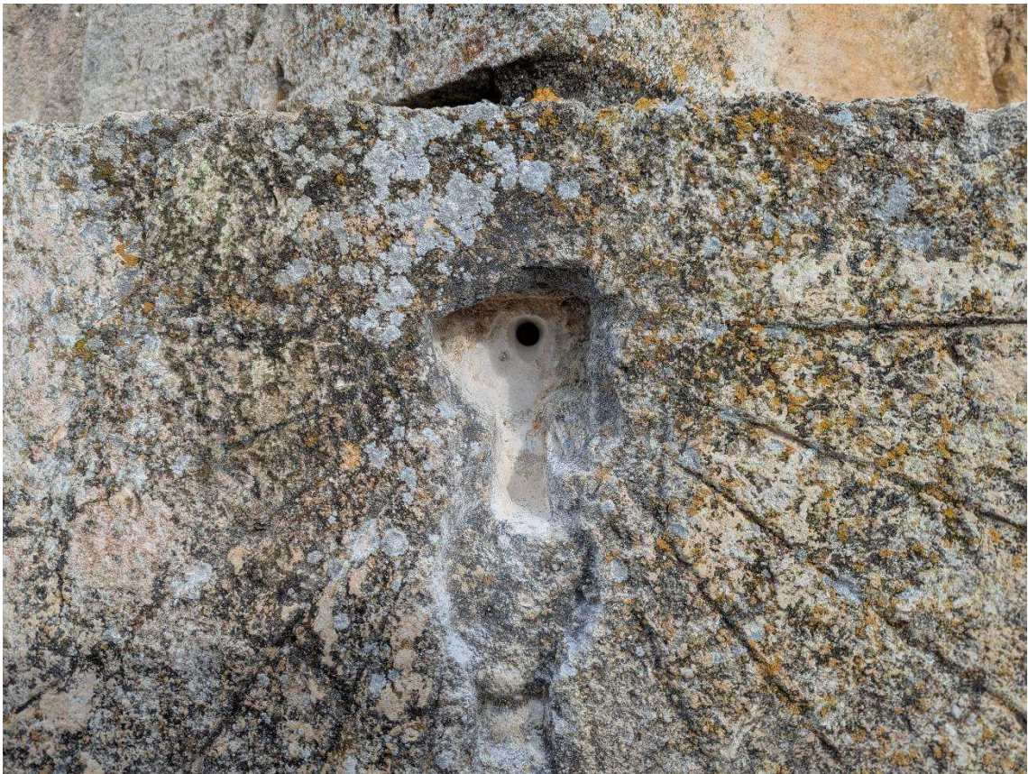
Figura 7. Agujero realizado mediante taladro para la correcta sujeción del nuevo gnomon.
