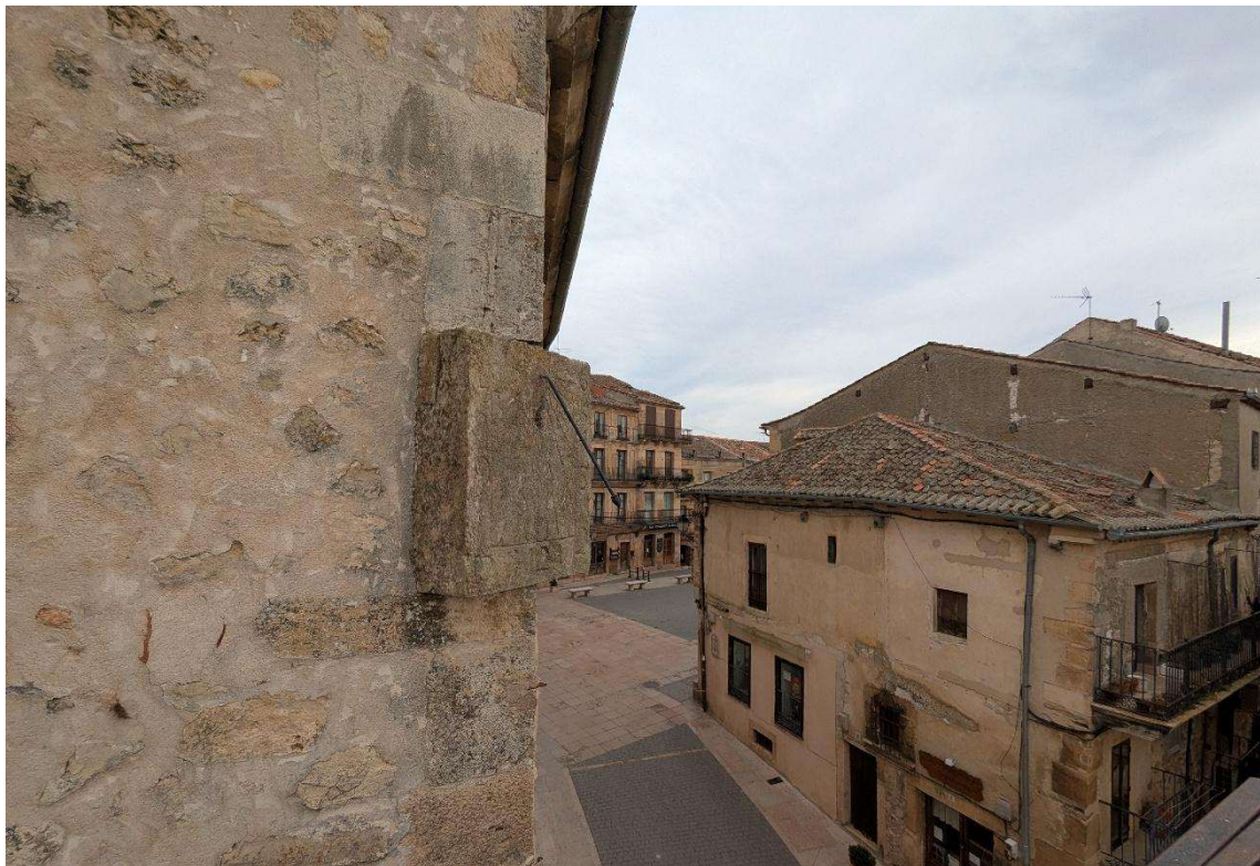
Figura 17. Proceso de aplicación del consolidante e hidrofugante una vez se había utilizado el elemento de desinfección y herbicida. En ella se aprecia el lateral occidental del reloj que fue intervenido también debido a la densa existencia de líquenes en el mismo.
