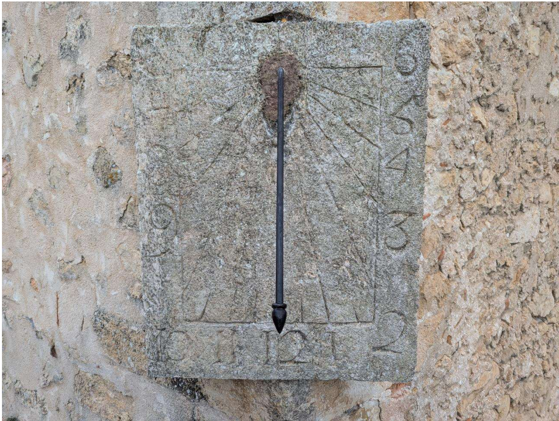
Figura 14. Fotografía tras el aplique de una pigmentación exterior al mortero, previamente testada, que tras la solidificación del mortero de cal y su ulterior aclaramiento, permitirá disimular el mortero de cal del sillar.
