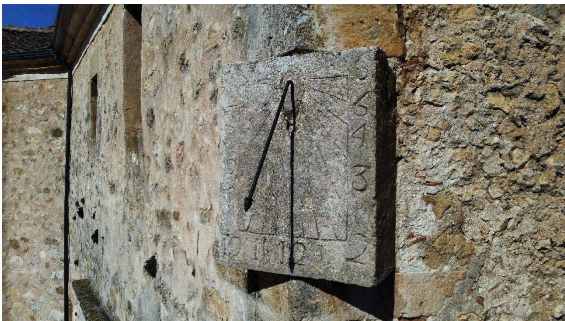
Figura 21. Fotografía tomada el 23/02/2026 una vez se secó el mortero de cal y la propia piedra en la que se observa el estado final del reloj de sol tras la restauración. Durante la visita se constató también la adecuación con respecto a la hora solar.
