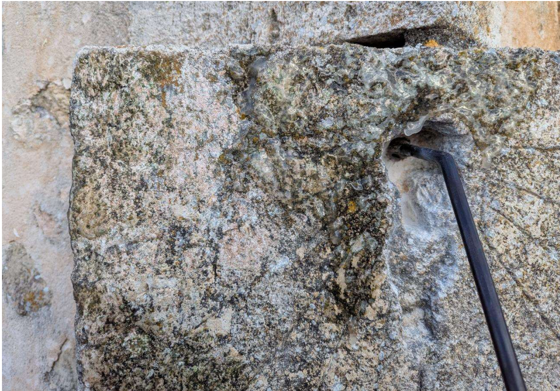
Figura 10. Detalle de la papeta B-57 en una de las zonas más afectada por los líquenes. Una vez surtía efecto con el paso de en torno a diez minutos, se procedía a su retirada junto con los elementos presentes en el exterior de la roca manualmente. En la foto se aprecia el gnomon con el taco químico ya solidificado.
