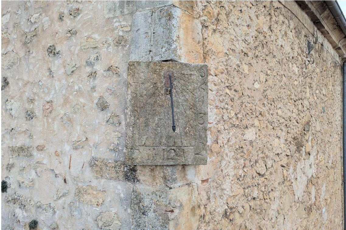
Figura 16. Detalle de la papeta B-57 en una de las zonas más afectada por los líquenes. Una vez surtía efecto con el paso de en torno a diez minutos, se procedía a su retirada junto con los elementos presentes en el exterior de la roca manualmente. En la foto se aprecia el gnomon con el taco químico ya solidificado.
